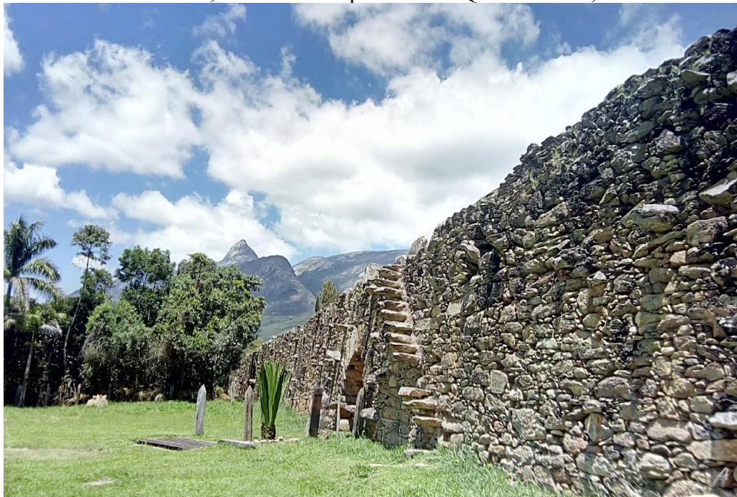
Figura 44: Bicame de Pedras, localizado no povoado de Quebra-Ossos, em Catas Altas (MG)
